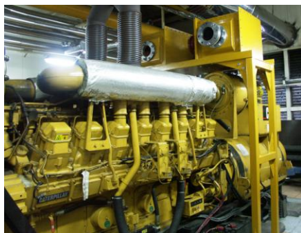
Rys. 3. Silnik dwupaliwowy Caterpillar 3516A w trakcie awarii pierwszego cylindra (fot. autora):
